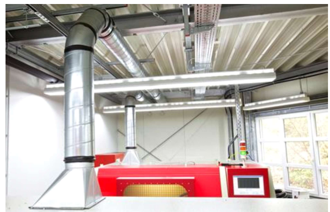
Bild 12: Absaugung an Prüfständen
